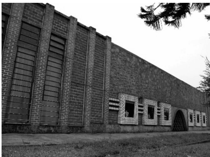
IMAGEM 11 – Fachada da casa de Heribert Gasa.
