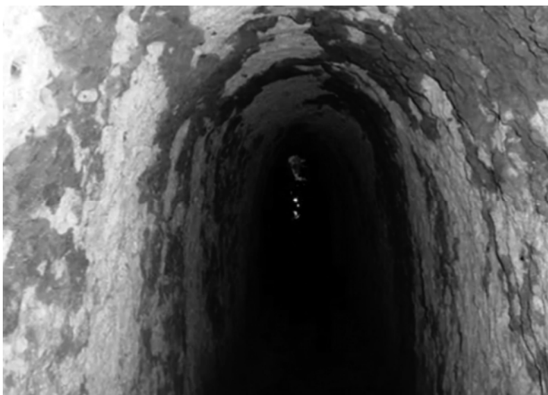
IMAGEM 17 – O casarão da Serra. Túnel que dá acesso à praia.
