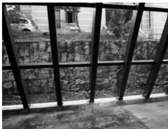
Figura 44 – Fachada de vidro vista por dentro do edifício.
