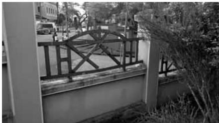
Figura 45 – Muro e grades de madeira.
